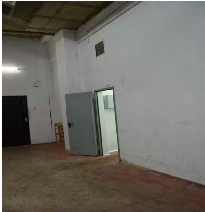
Vista interior de las zonas comunes del área de carga y descarga
