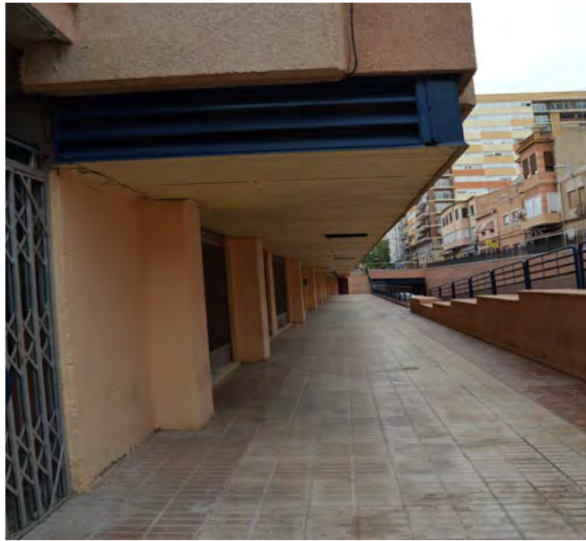
Vista del pasillo exterior inferior que da acceso a los locales
