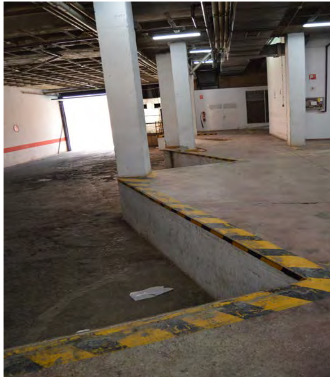
Vista del acceso al muelle de carga y descarga
