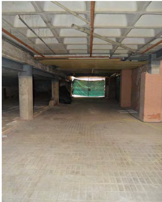
Vista del interior del local bajo el acceso desde Calle Juan Carlos I
