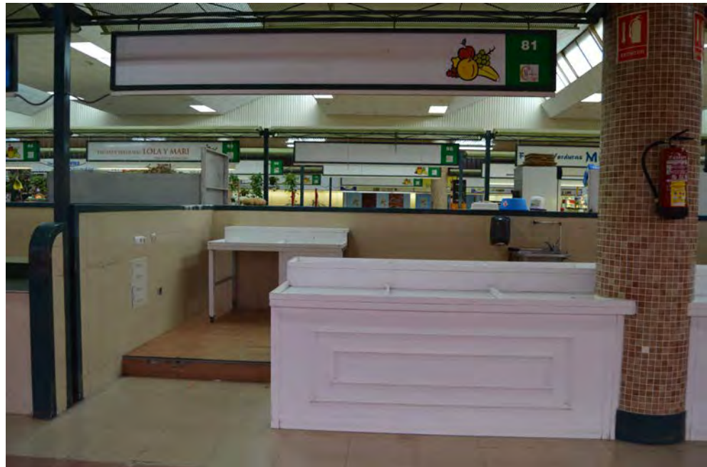
Señalética de evacuación y extintores en la sala del mercado
