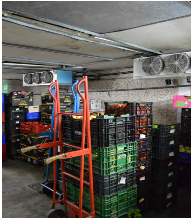
Vista del interior de una de las cámaras de frutas
