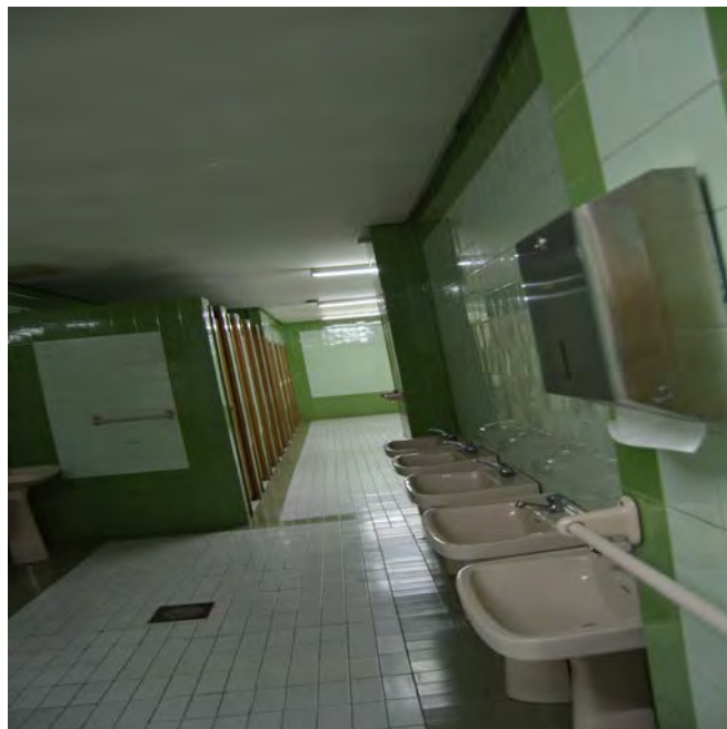
Vista del interior de los aseos para trabajadores
