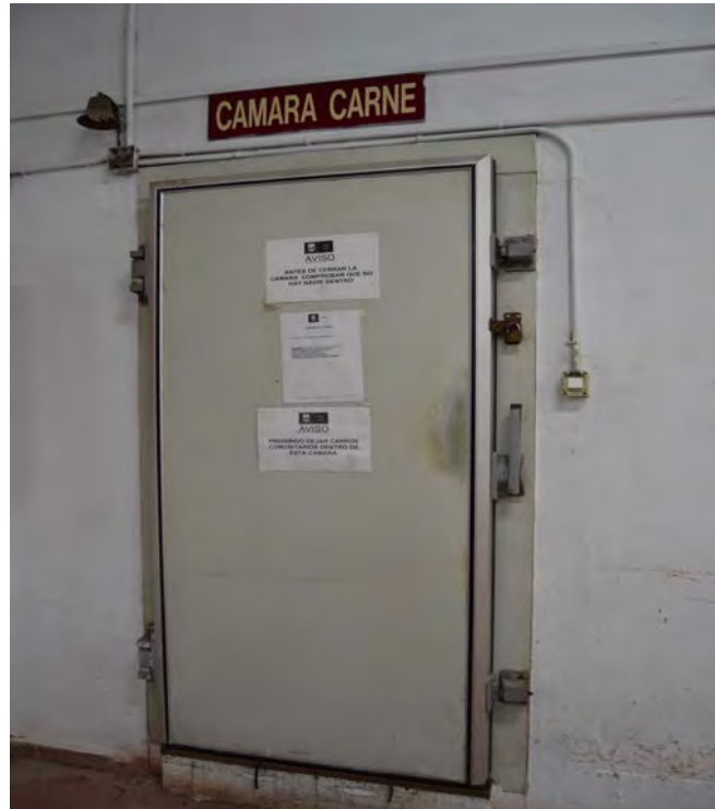
Vista de la puerta de acceso a la cámara de carnes (ausencia de pre cámaras)
