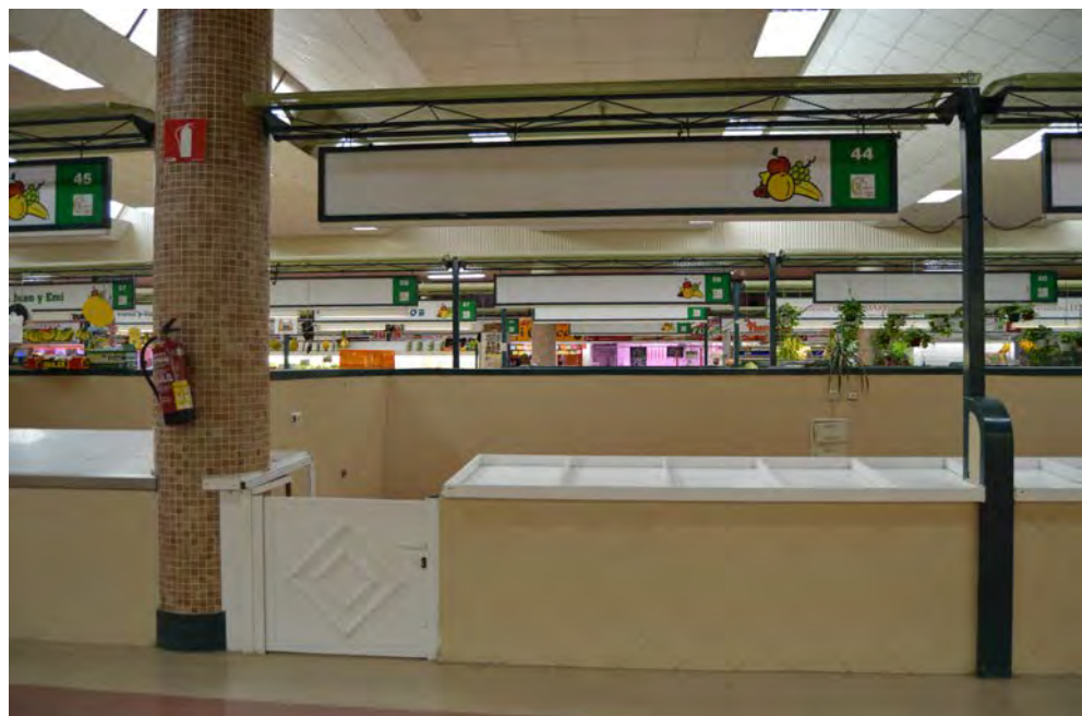
Vista de puesto tipo de las islas centrales de la Fase 02 con mostrador
