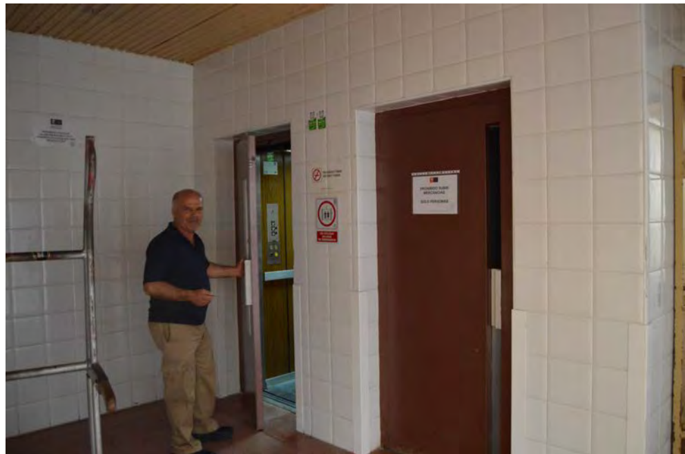
Vista de los montacargas
