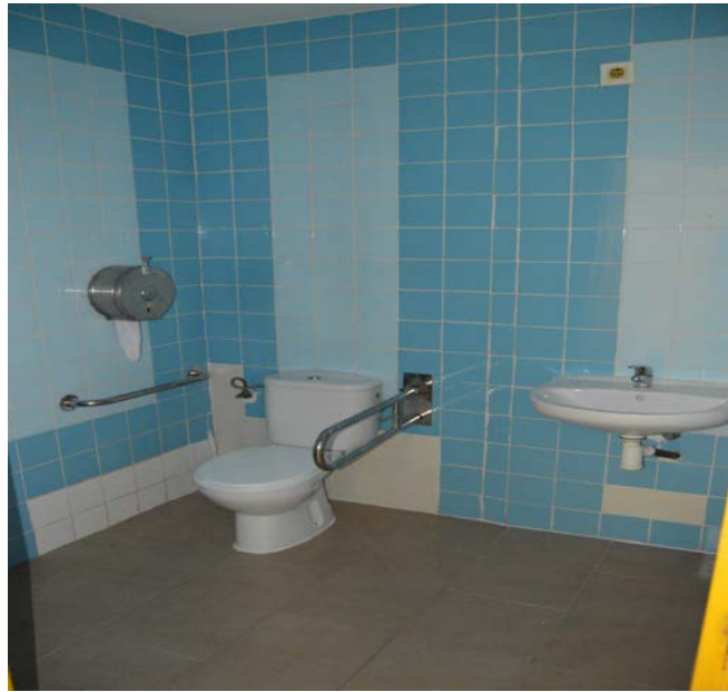
Vista del baño para p.m.r (Necesaria comprobación de la normativa de accesibilidad)
