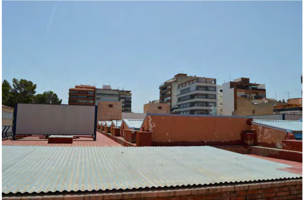
Vista de la cubierta de la Fase 2, se observa la ocupación de la misma por la maquinaria del centro
