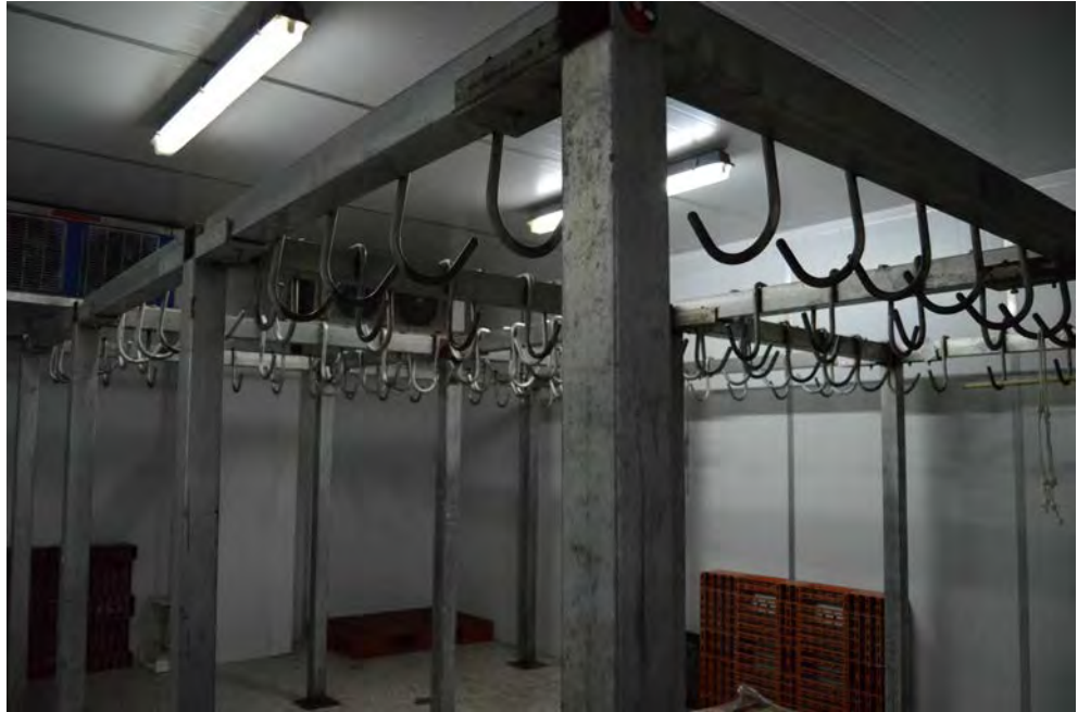
Interior en desuso de cámara de carnes
