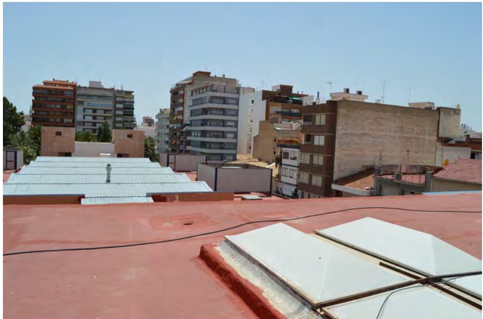
Vista general de las cubiertas de cada fase
