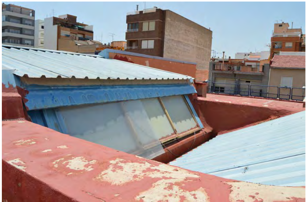
Vista de los lucernarios de la Fase 2
