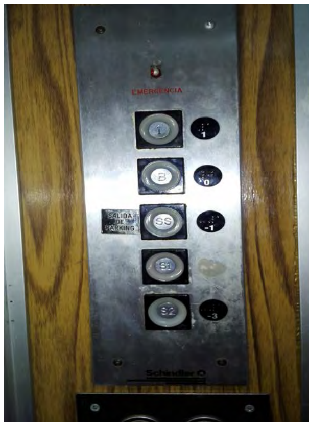
Ausencia de señalética en el ascensor público desde el aparcamiento
