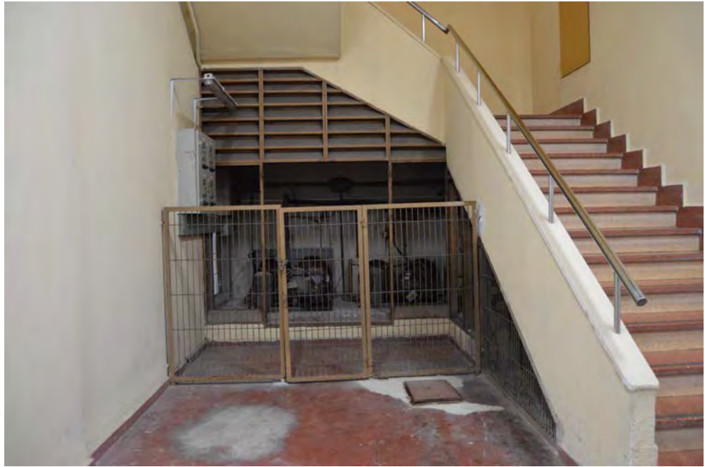
Vista del inicio de las escaleras desde planta sótano
