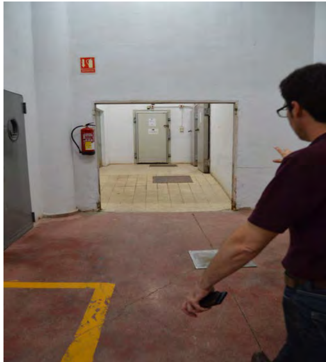
Vista del muelle de carga hacia el acceso al área de cámaras (Ausencia de pre cámaras)
