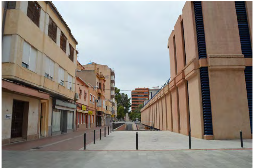
Vista fachada Fase 2 hacia Calle María Guerrero
